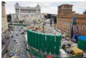
Cantiere stazione Venezia
